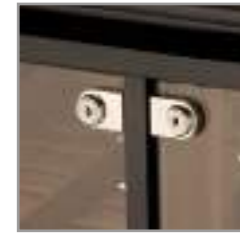
Vetrine con chiusure di sicurezza Glass windows with safety lock
